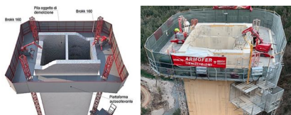
Figura 3-14 – Alternativa 2A e 2B – Demolizione della pila dalla sommità, per H elevate
