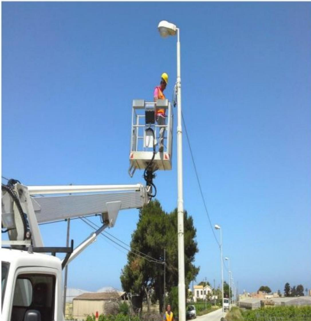
I lavori sono stati consegnati in data 23/08/2021 e sono in corso di realizzazione. Lavori eseguiti: ad oggi sono stati sostituiti circa 5300 corpi illuminanti con altri a LED e circa ml 1.000 di linee elettriche aeree in precordato.
