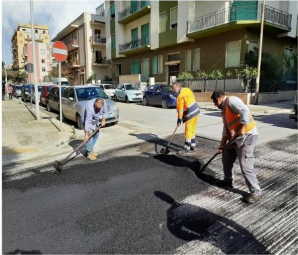
del manto di usura di alcuni tratti stradali ammalorati (in alcuni casi anche degli strati di collegamento), nella riparazione o rifacimento di marciapiedi, ecc., sono stati ultimati in data 16/03/2022.
