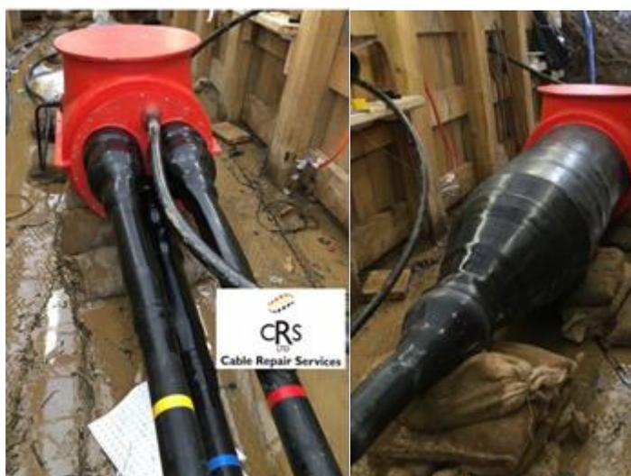
Figura 42: Giuntura di transizione sulla terraferma.
