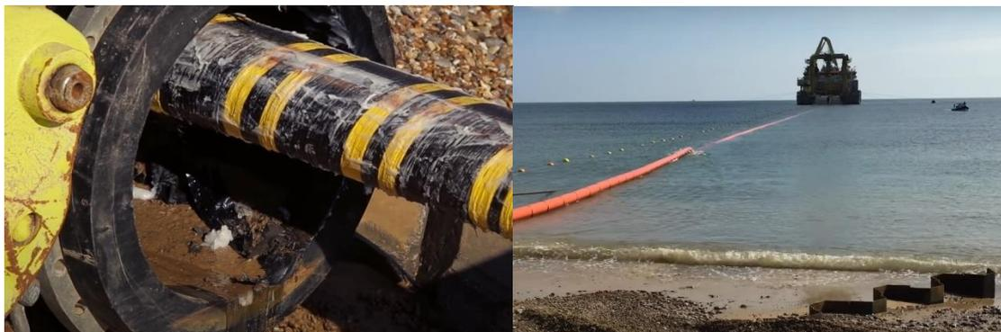
*Figura 45: Inserimento di un cavo export offshore sulla riva.*
