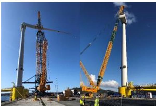
Figura 37: Installazione della turbina eolica.
